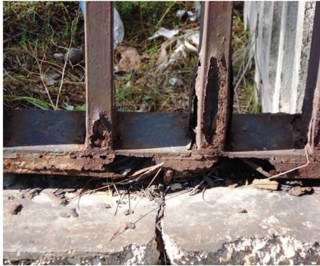
che la recinzione in ferro, che delimita l'area delle ferrovie dello Stato, è arrugginita ed in alcuni punti molto pericolosa perché corrosa alla sua base da cui fuoriescono pezzi di ferro distaccati dalla
